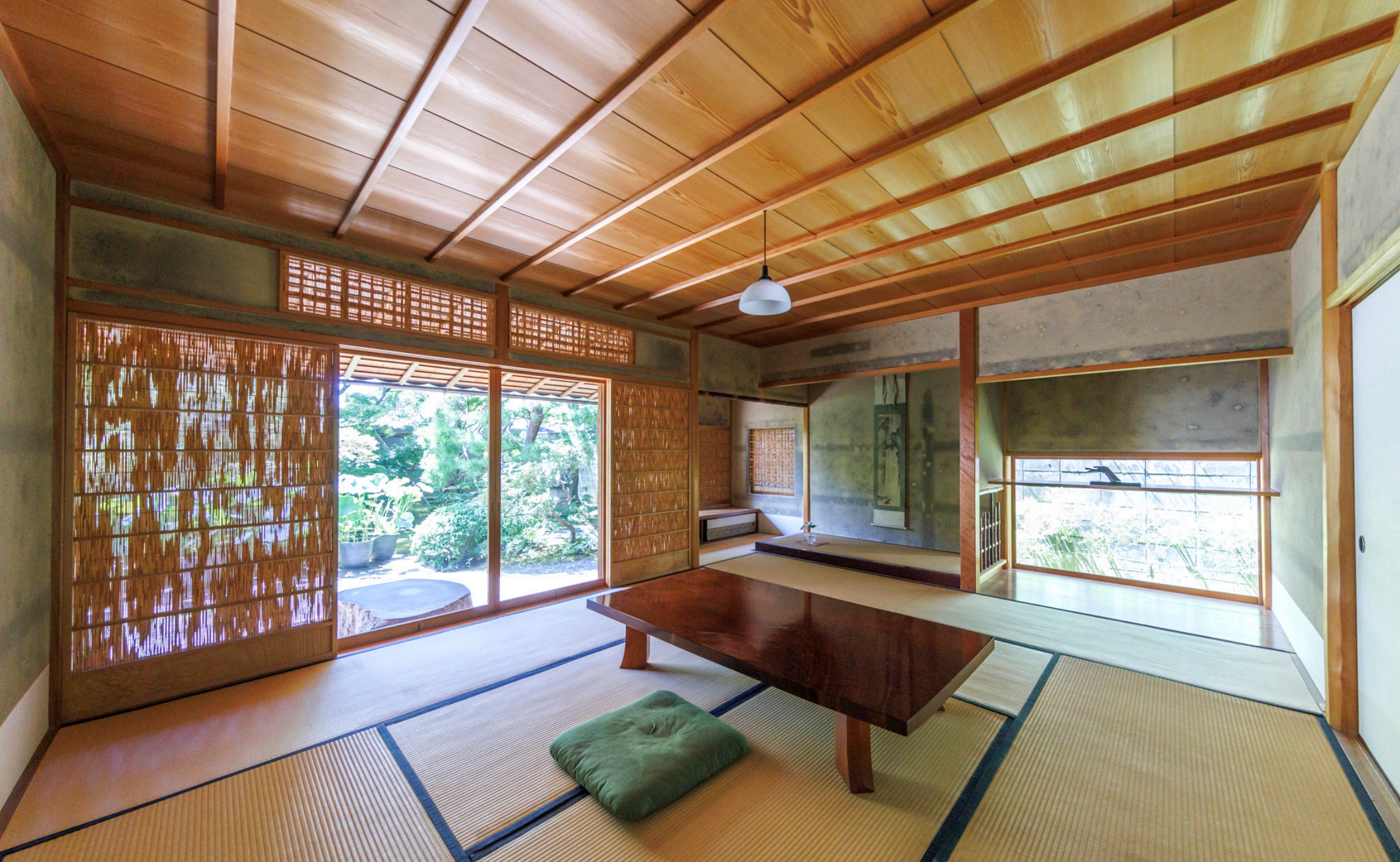
出書院のある10畳の座敷。障子を夏用の簾戸に替えている。柱は北山丸太の4面を削って杳目を見せた面皮柱。小径の北山丸太が支える土庇が庭に向かって伸び、建物と庭とを結びつける役割を果たしている。
