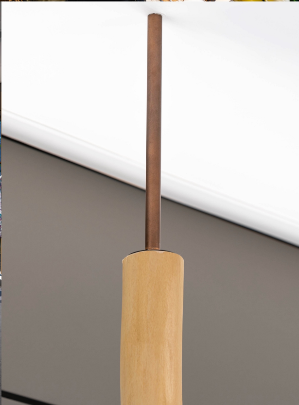
北山丸太を縦使いするときは上下に金属棒を入れて床・天井に固定した。
