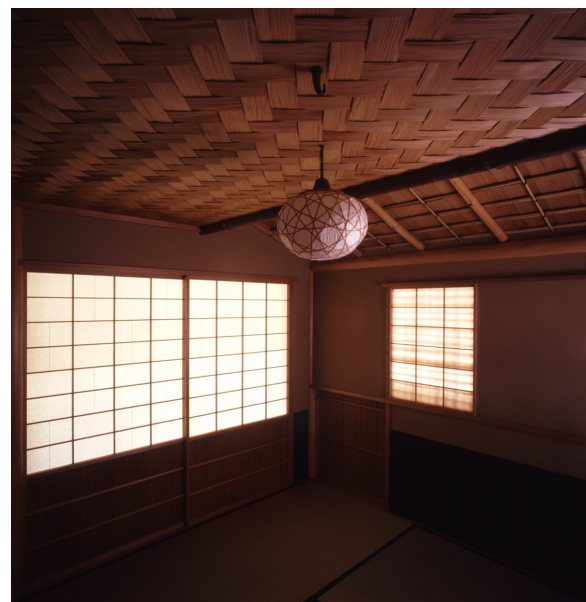
霧月化粧軒裏天井（左）。 桁・柱・隅木に北山磨丸太が使われている。裏板は黒部杉板、女竹藤蔓巻き。
